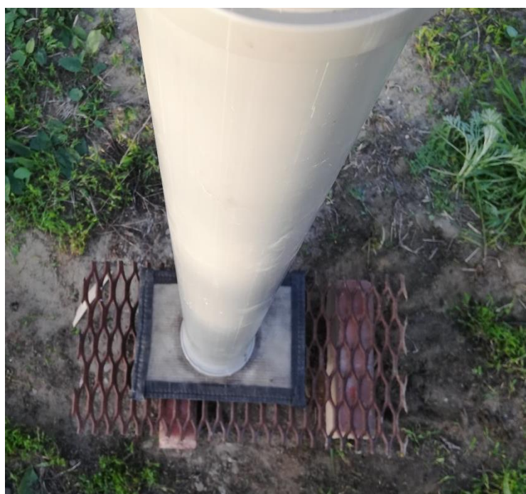
Рисунок 4.2 – Установленный и закреплённый столб воды
