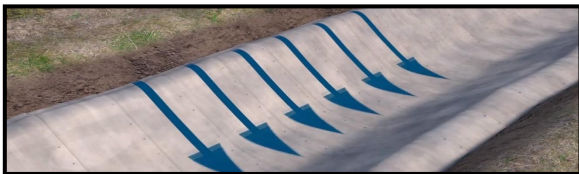
Рисунок 1.21 - Покрытие канала поперек с помощью бетонного полотна
