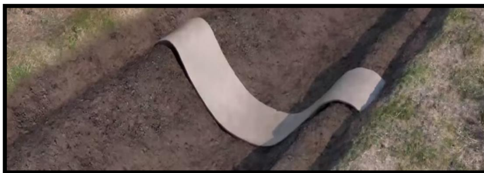
Рисунок 1.23 - Укладка бетонного полотна с установкой краёв в анкерные пазы
