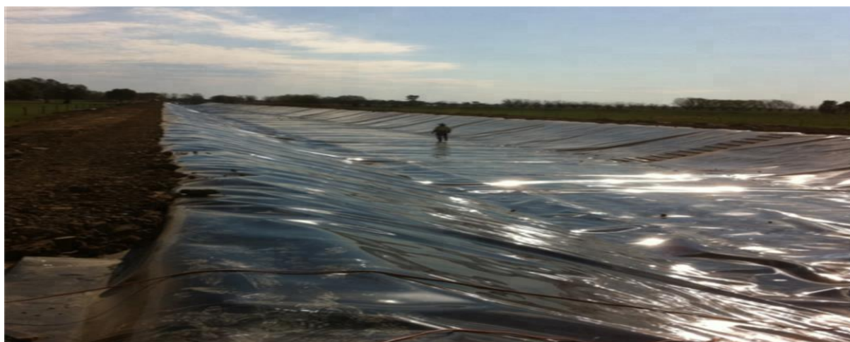
Рисунок 1.15 – Облицованный геосинтетической мембраной оросительный канал
