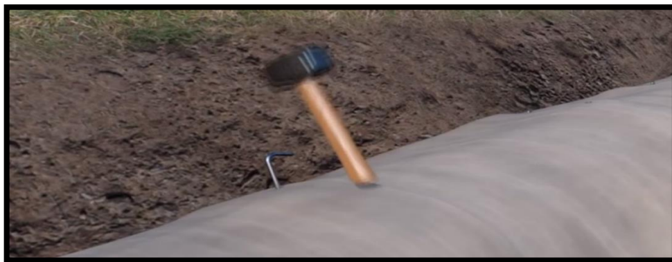
Рисунок 1.24 - Закрепление бетонного полотна кольями в анкерных пазах
