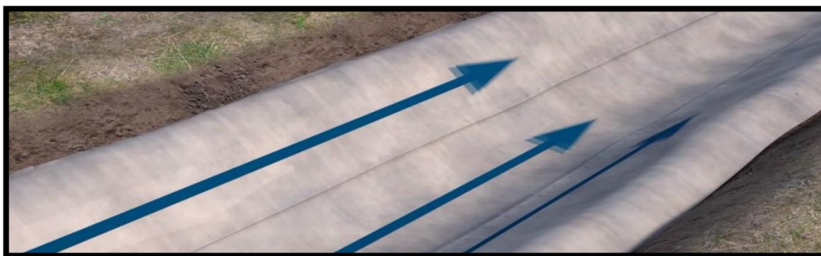
Рисунок 1.20 - Покрытие канала вдоль с помощью бетонного полотна
